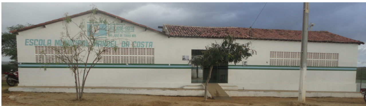
Figura 1. Fachada da Escola Municipal Manoel da Costa. Fonte: Nunes, A. C. F. (2014).
