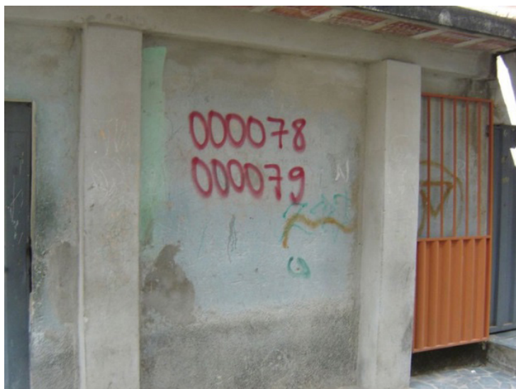
Fotos 1 e 2: Selagem das casas a serem demolidas
