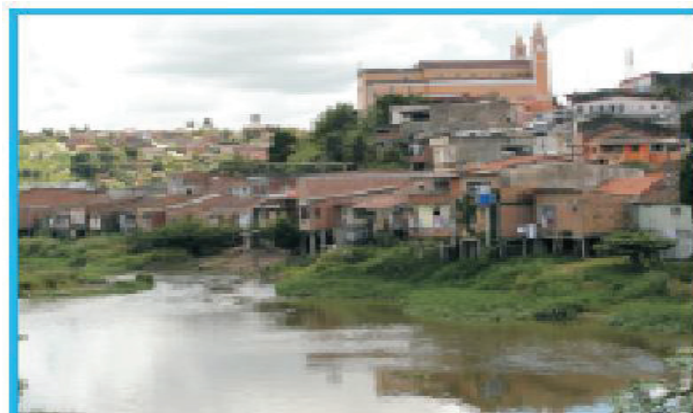
Figura 2: Residências no bairro Centro em Escada as margens do rio Ipojuca
