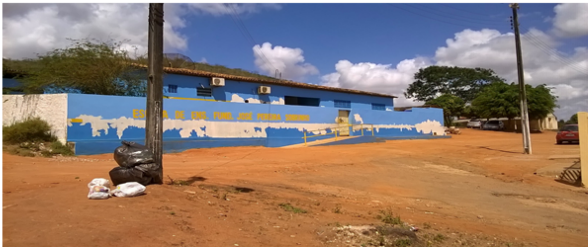
Figura 06: Escola de Ensino Fundamental José Pereira Sobrinho – Zona Rural de Arapiraca/AL.
