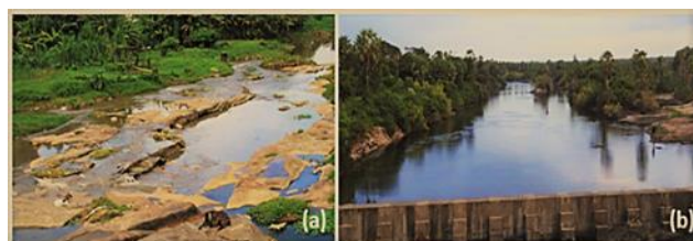
Figura 2 - Principais subsistemas de abastecimento de água da RMR/PE: Jangadinha (a) e Caixa D'Água (b)
