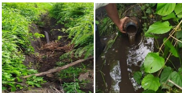
Figura 2. Extremidade do tubo coletor
