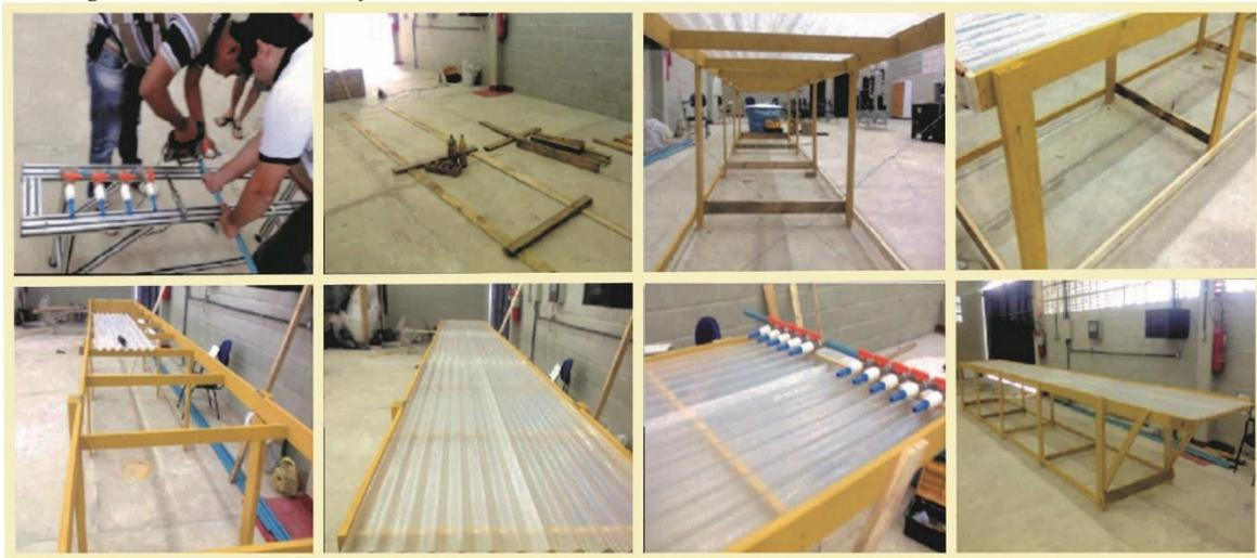
**Figura 3** – Sistema de derivação e manômetros já instalados no módulo didático.
